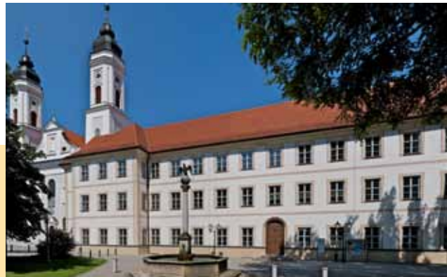
Hohes Einsparpotential durch energetische Sanierung in Kloster Irsee, Bild: Achim Bunz
