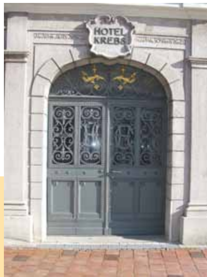
Ein städtebaulicher Gewinn: Das sanierte Hotel Krebs in Donauwörth
