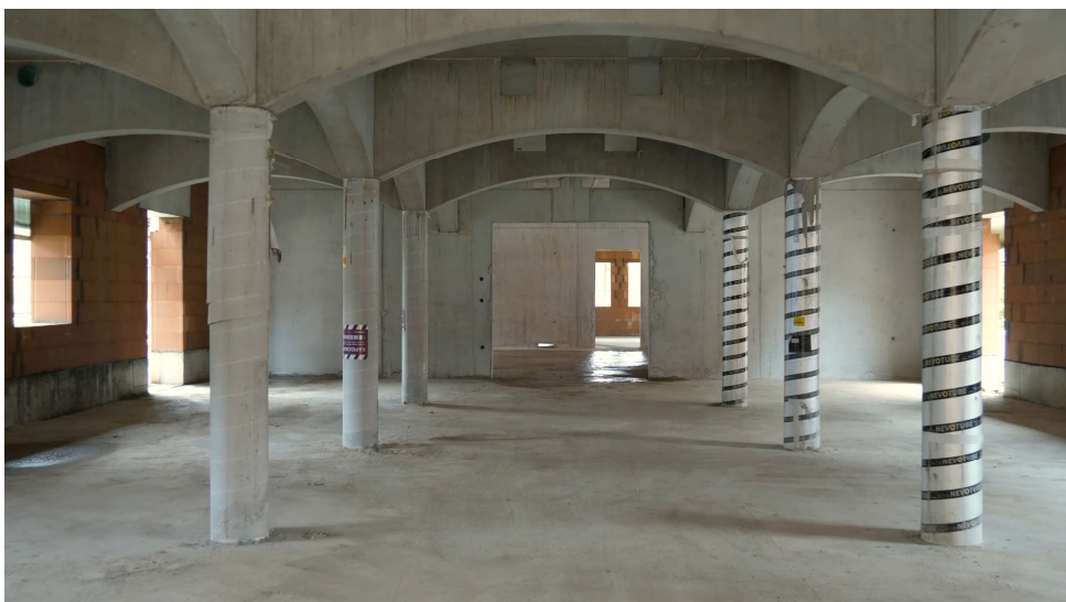
Säulensaal des Kunst_Raums Weiherhof während der Bauarbeiten
