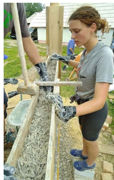
Erste Erfahrungen mit der Verarbeitung von Hanf-Kalk als Baumaterial
